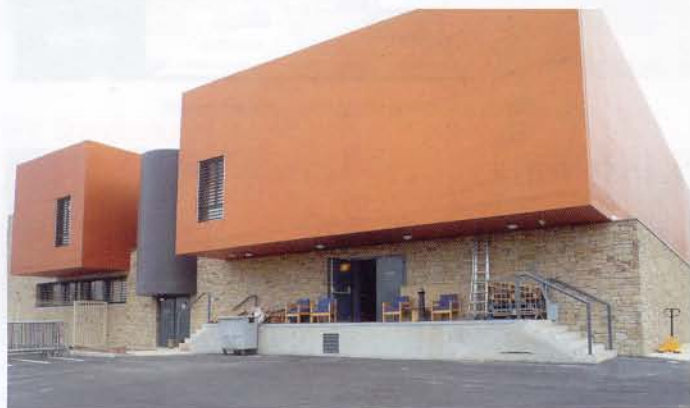
Quai de déchargement sans ses gardes corps
