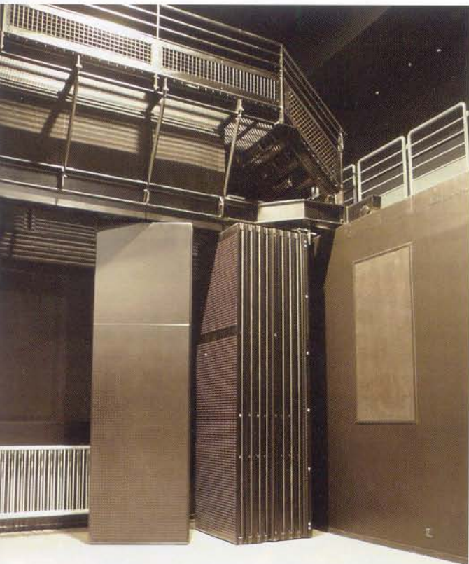
Dispositif de réduction de salle avec son panneau acoustique repliable
