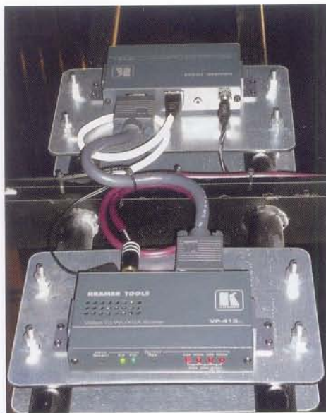
Astucieux boîtiers distributeurs vidéo répartis dans tout le lieu via réseaux RJ 45 Cat
