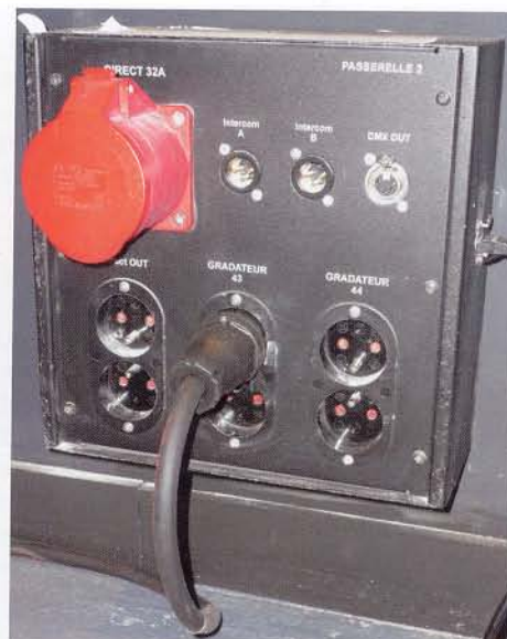
Rien ne manque : P17.32 A TRI + PC 10/16 A + DMX + RJ 45 + XLR audio
